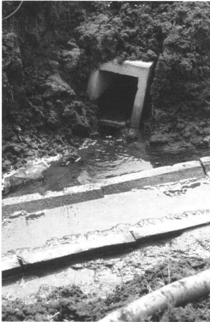
Abb. 3: Einmündung eines Sammlers in einen Vorflutgraben (Drainage bei Michałowice, Südpolen).
