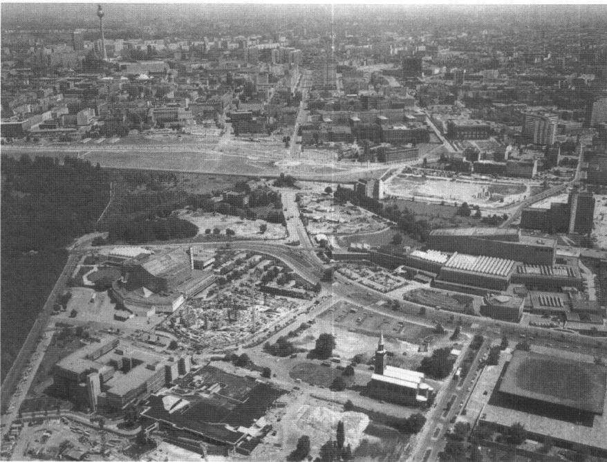
Abb. 10: Potsdamer Platz: Dieser Bereich wird für das Zusammenwachsen der beiden Stadthälften von grosser Wichtigkeit. Das im Oktober 1991 preisgekrönte Wettbewerbsprojekt von Hilmer & Sattler sieht wieder ein lebendiges Zentrum vor. Oben: Potsdamer Platz um 1925. Unten: Potsdamer Platz mit Mauer um 1985.
