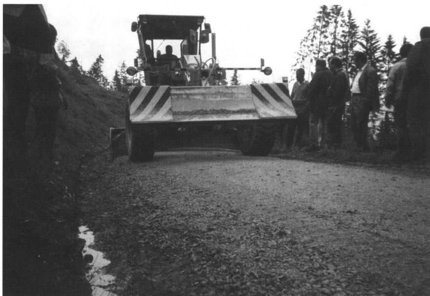
Abb. 4: Der erfahrene Maschinist und der bombierte Schild des Graders schaffen ein optimales Profil.
