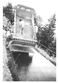
Abb. 3: Einfache OB; der Belagswulst schützt das Bankett gegen Strassenwasser.
