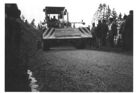
Abb. 4: Der erfahrene Maschinist und der bombierte Schild des Graders schaffen ein optimales Profil.
