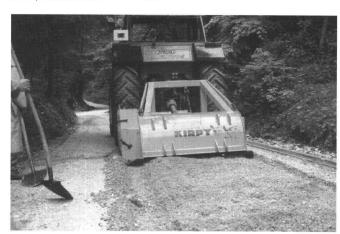
Fig. 3: Démonstration d'un concassage mobile.
