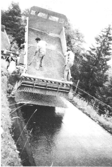
Abb. 3: Einfache OB; der Belagswulst schützt das Bankett gegen Strassenwasser.
