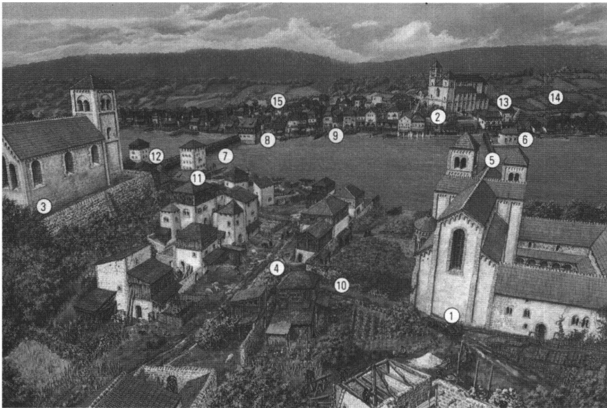
Zürich um 1300. 1 Fraumünster 2 Grossmünster 3 St. Peter 4 Archäologisch gefasste «Ur«-Münsterhof-Häuser 5 Obere Brücke, Fussgängersteg 6 Wasserkirche 7 Untere, ältere Brücke 8 Rathaus 9 Fischmarkt 10 Immunitätsmauer der Abtei Fraumünster 11 Roter Turm 12 Schwert-Turm 13 Hottinger-Turm und Grafenhof 14 Wies- und Rebgebäude 15 Siedlungskern Rindermarkt-Neumarkt.
