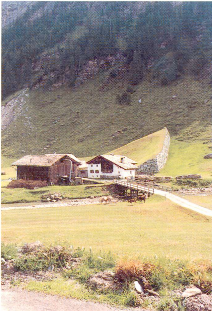
Abb. 7: Direktschutz; Spaltkeil, Weiler Ramsa im Val Madris (GR) (Foto A. Burkard).
