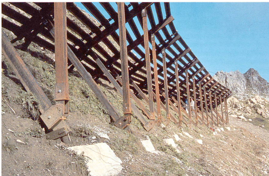
Abb. 4: Bremsböcker und Auffangdamm im Dorftäli – Lawinenzug zwischen Weissfluhjoch und Davos (Foto SLF).
