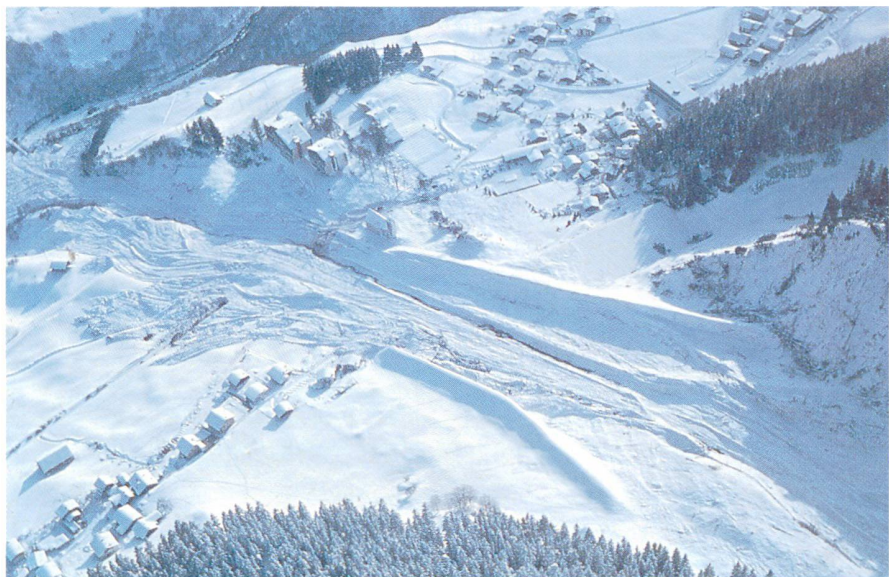
Abb. 3: Ablenkerwerke bei Disentis; Schutz vor Sogn Placi-Lawine. Ereignis vom 10.2.1984 (siehe Abb. 8).
