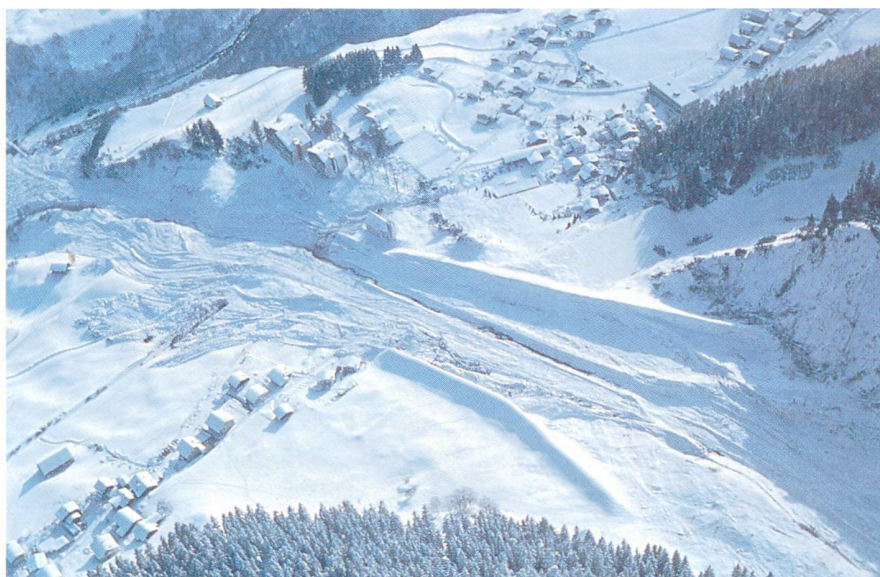
Abb. 3: Ablenkwerke bei Disentis; Schutz vor Sogn Placi-Lawine. Ereignis vom 10.2.1984 (siehe Abb. 8).
