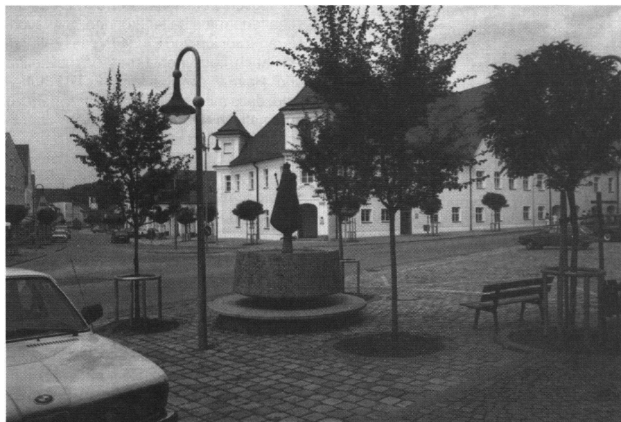
Abb. 1 und 2: Dorferneuerung Arnstorf: Schlossgebäude am Marktplatz vor und nach der Renovation des Schlosses und der Neugestaltung des Marktplatzes.
