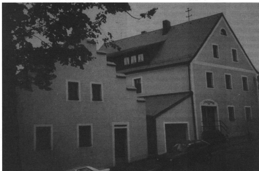
Abb. 5 und 6: Dorferneuerung Leuchtenberg: Gasthof mit eigener Metzgerei vor und nach der Renovation.
