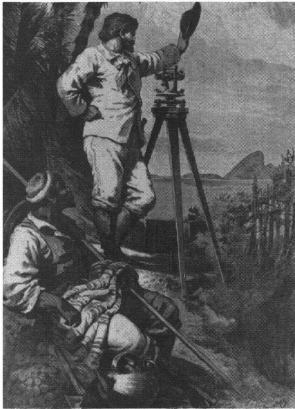
Abb. 6: Strassenbau in Brasilien.
