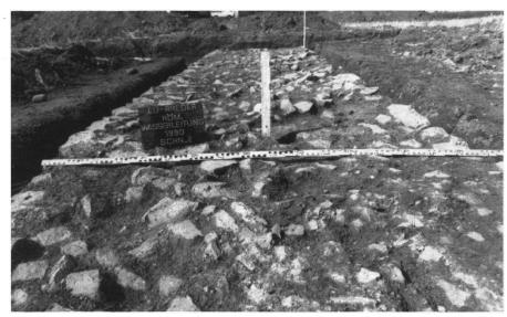
Abb. 13: Römische Eifelwasserleitung nach Köln; Unterbau der Rampe zur Aquäduktbrücke über die Erft. Ein rechteckiger Hohlraum im Gussbeton bezeichnet den ehemaligen Standort eines Messpfählchens (Im Foto ist die Situation nachgestellt).
