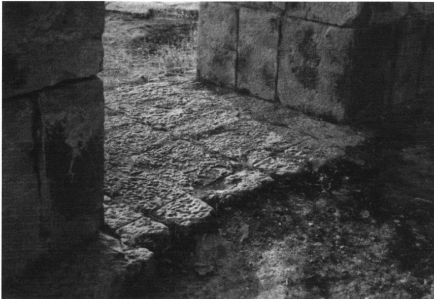
Abb. 14: Ritzlinien zur Bauabsteckung im Fundament des Amphitheaters der römischen Stadt Bulla Regia (Tunesien).
