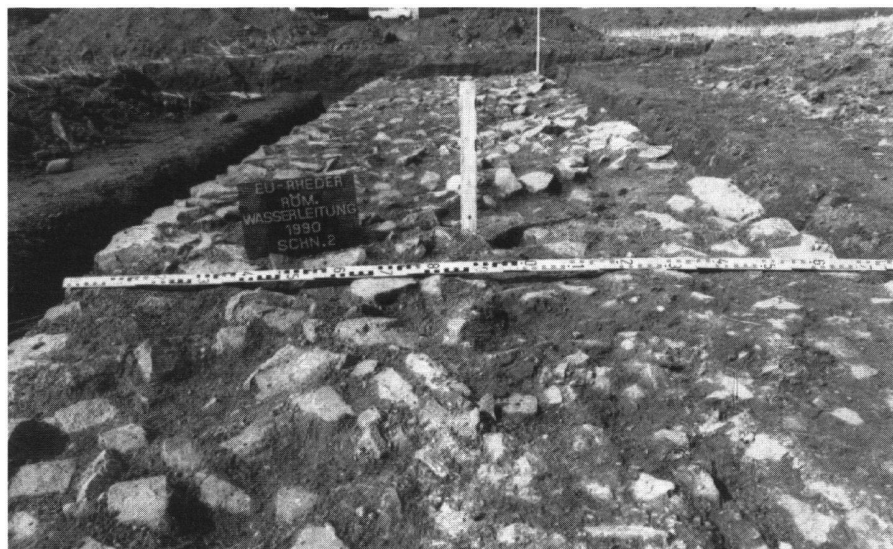
Abb. 13: Römische Eifelwasserleitung nach Köln; Unterbau der Rampe zur Aquäduktbrücke über die Erft. Ein rechteckiger Hohlraum im Gussbeton bezeichnet den ehemaligen Standort eines Messpfähchens (Im Foto ist die Situation nachgestellt).
