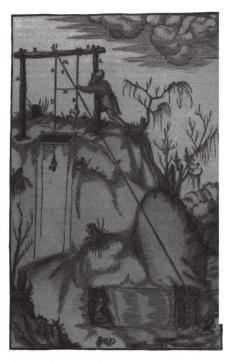
Abb. 1: Markscheiderische Vorausbestimmung der Schachttiefe und Stollenlänge am Durchschlagspunkt von Schacht und Stollen (aus: G. Agricola «De re metallica», Basel 1556).
