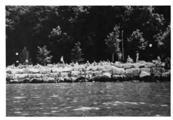
Abb. 9: Aufschüttung einer Flachwasserzone und Uferabschluss durch Blockwurf (Stansstad).
