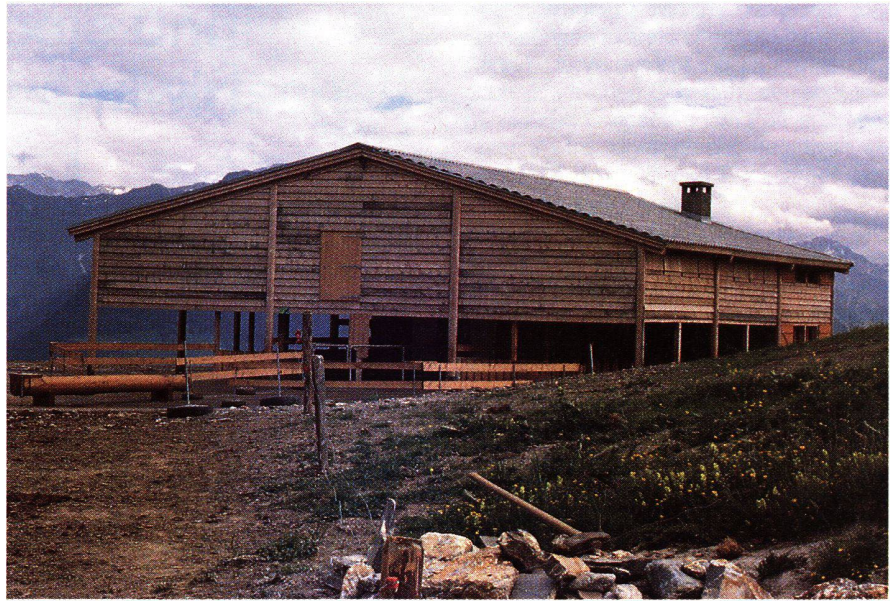
Abb. 5: Alp Morrissen, Betriebszentrale.
