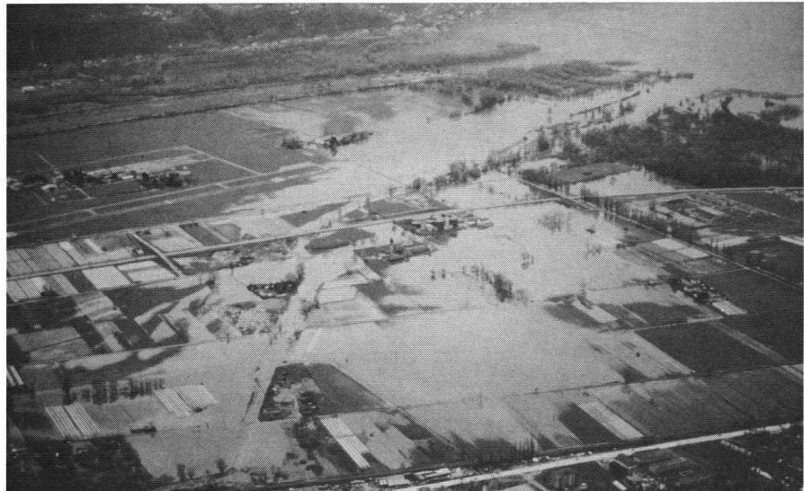
Fig. 1: Piano di Magadino: Periodici allagamenti dovuti all'innalzamento del livello del Lago Maggiore.
