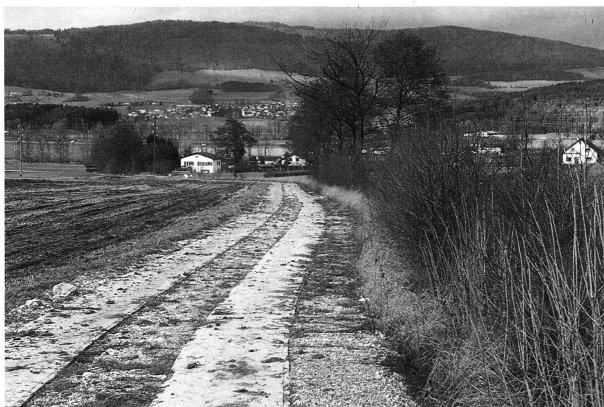
Fig. 5: Chemin avec bandes de roulement dans le remaniement parcellaire de Bassecourt avec une pente de 7 à 8% (construction en 1989, photo en 1991).
