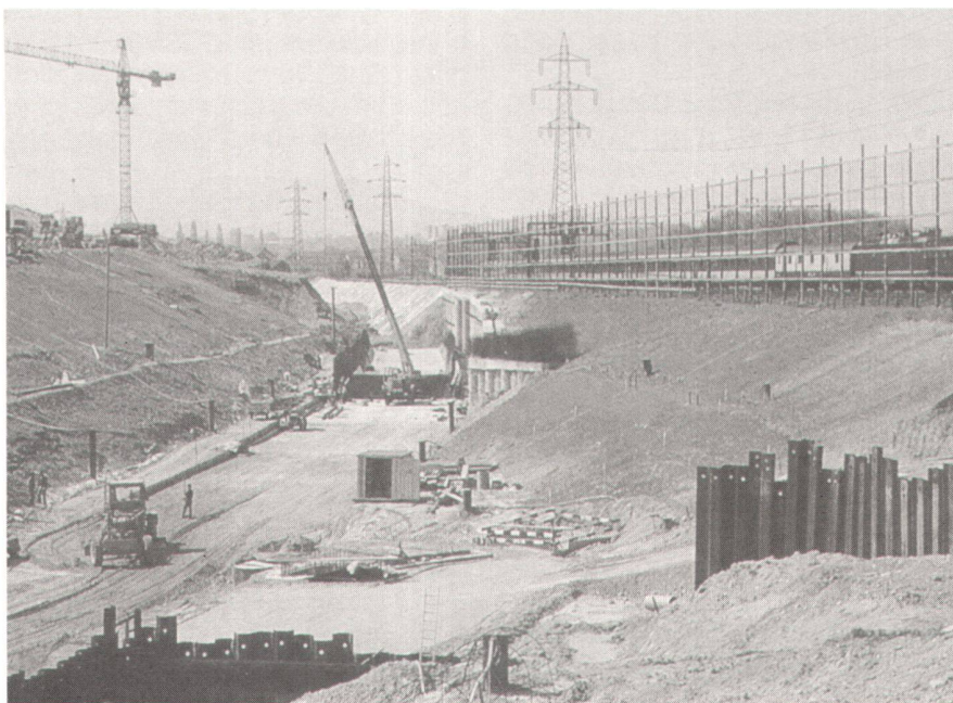
Abb. 3: Grauholztunnel bei Bern. Die Tunnelzufahrt Seite Bern nimmt Gestalt an. Die heutige Linie wird 1991 auf die andere Seite des Einschnitts verschoben.
