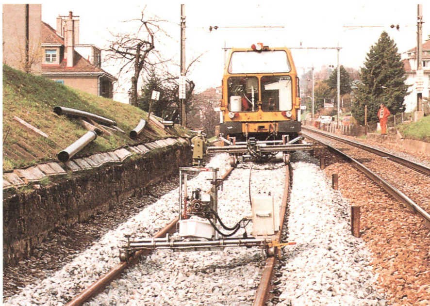
Abb. 10: Automatische Richt-, Nivellier- und Stopmaschine ausgerüstet mit dem neuen Lasersystem. Mit dem Distanzmesser im Vordergrund wird die Horizontaldistanz und die Höhendifferenz zum Gleisversicherungspunkt gemessen. Der Bordcomputer ermittelt durch den Vergleich der Ist-Werte mit den Soll-Werten die effektive Schiebung bzw. Hebung in diesem Punkt.
