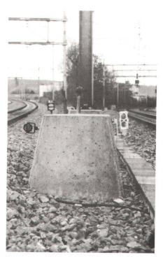
Abb. 5: Wildreflektoren (Typ GPH1) können direkt an den Bolzen gesteckt werden. Für Prismen, die zur Messung senkrecht stehen müssen, sind Haltebügel entwickelt worden.
