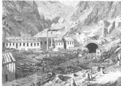
Abb. 1: Die Werkplatzeinrichtungen vor dem Nordportal in Göschenen.
