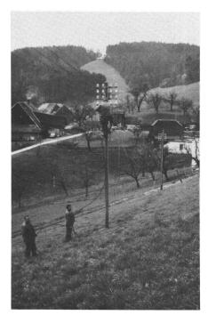
Abb. 6: Freileitung: Ersatz einer konventionellen Freileitung durch ein Luftkabel.
