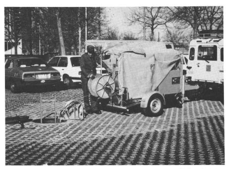
Abb. 8: Kabeleinzug: Vorbereitungsarbeiten für den Einzug eines Glafaserkabels. Tirage de câble: préparation des travaux pour le tirage d'un câble à fibres optiques.
