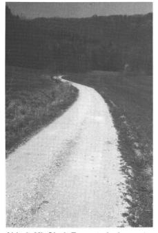
Abb. 2: Mit Glorit-Zementmischung stabilisierter Weg. Einige Stellen mit stärkerer Verkittung sind schwach erkenntlich.
