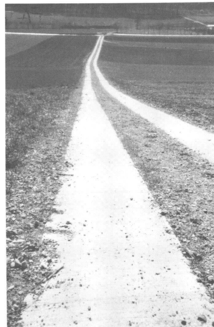
Abb. 5: Betonspurweg ein Jahr nach der Erstellung.
