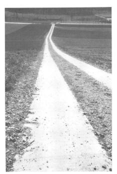
Abb. 5: Betonspurweg ein Jahr nach der Erstellung.
