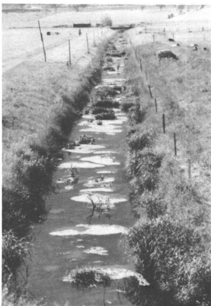
Abb. 3: Ein typischer Kanal ohne Gefälle bei Schänis: die starke Verkrautung bedingt zwar viel Unterhalt, hat aber eine beträchtliche Selbstreinigung des Gewässers zur Folge und birgt Lebensraum für zahlreiche Wassertiere.
