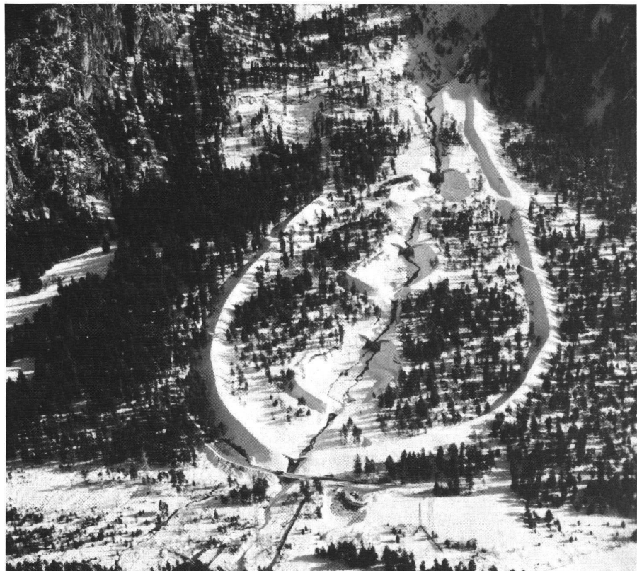
Abb. 4: Tränenbach in der Gemeinde St. Anton im Montafon: Die drei Geschiebeablagungsplätze wurden durch grössere Umfassungsdämme zu einem einzigen vereint.
