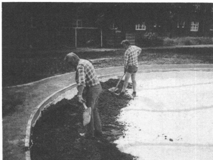
Schutzschicht aufbringen...
