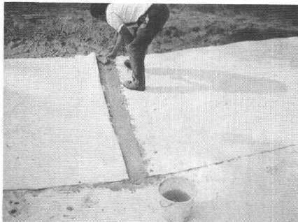
mit einer anzurührenden Derneton-Paste dünn einstreichen und Nahtstellen abdichten...
