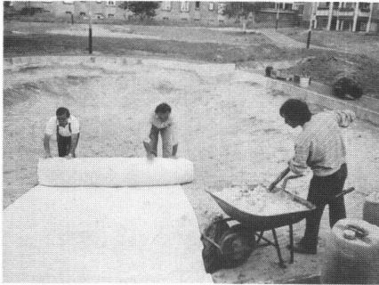
Derneton-Abdichtungsvlies ausrollen...
