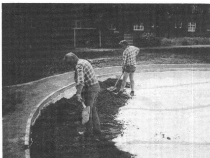
Schutzschicht aufbringen...
