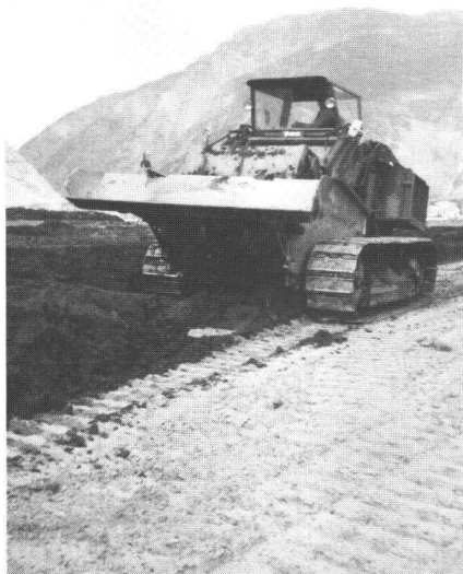
Abb. 5: Vorbereitung eines Mischbo-dens mit Schürfkübel.
