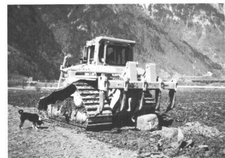
Abb. 6: Tieflockerer auf Schüttung im Einsatz.
