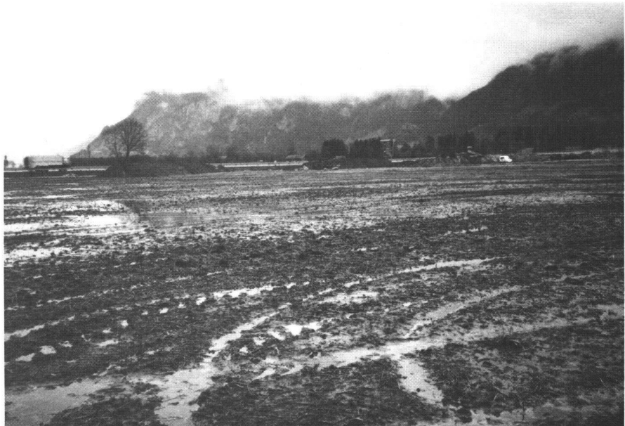
Abb. 7: Stauwasser auf Schüttung in Seedorf.
