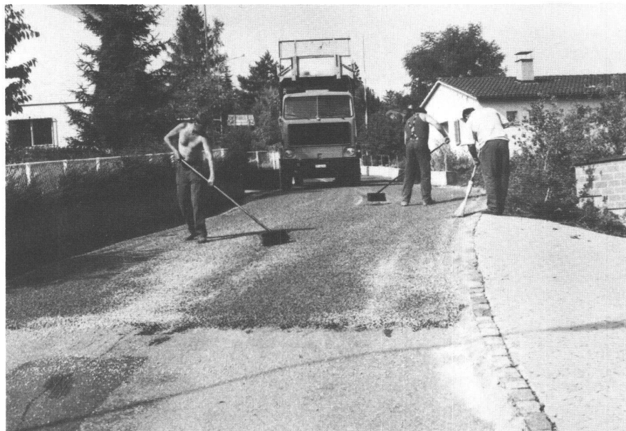
Abb. 5: Baulicher Strassenunterhalt (Foto: R. Crivelli, Bauamt Baar).
