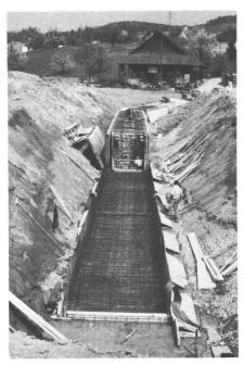
Abb. 4: Anpassung der Abflussverhältnisse an die Siedlungsentwicklung: Bau eines Entlastungskanals und Meteorwasserkanalisation
