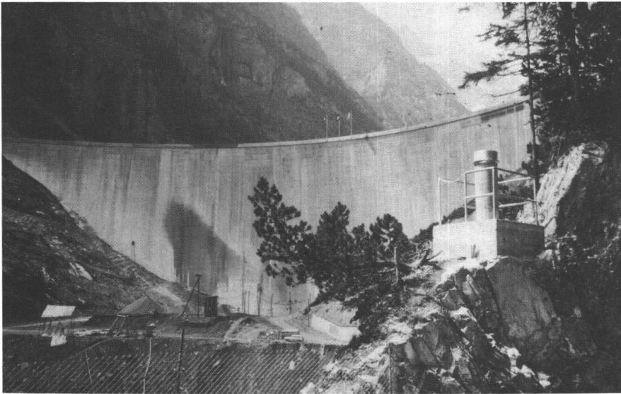
Abb. 4: Messstation vor der Staumauer. Die Deformationsmessungen beginnen schon während der Bauzeit. (Foto: W. Schneider AG).
