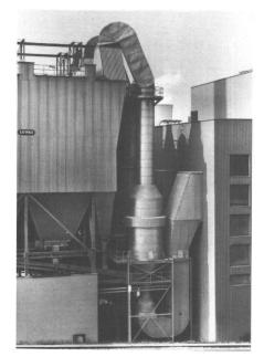
Abb. 3: Rauchgasreinigungsanlage der MVA Schwandorf mit Elektrofilter und Trockengasreaktor.
