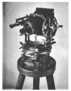
Abb. 1: Erster Phototheodolith der L+T, verwendet von M. Rosenmund 1892.
