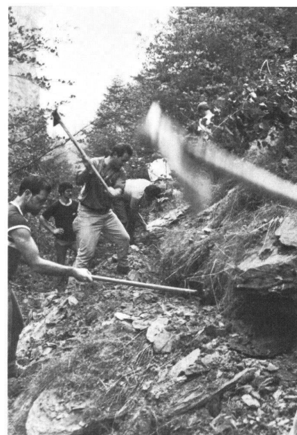
Abb. 1: Hangeinschnitt zum anschliessenden Einbringen einer Busch- und Heckenlage.
