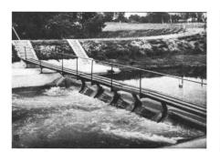
Abb. 8: Sogenanntes Bockswehr von Kwapiszewski am Kanal Wieprz-Krzna
