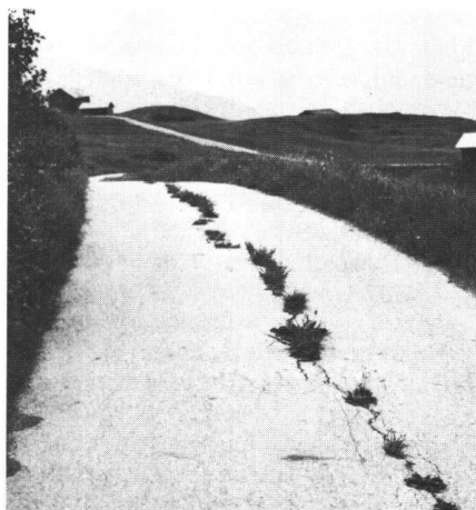
Abb. 2: Solche bereits bewachsenen Längsrisse in der Strassenmitte (Frostschäden) können im Rahmen des laufenden Unterhalts einfach repariert werden, indem die Schadstelle gereinigt, die Risse mit Bitumenemulsion ausgegossen, übersplittet und festgestampft werden (Foto: Ch. Boss).
