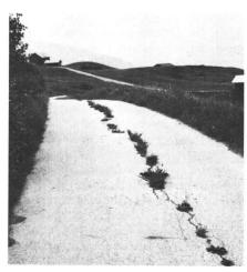
Abb. 2: Solche bereits bewachsenen Längsrisse in der Strassenmitte (Frostschäden) können im Rahmen des laufenden Unterhalts einfach repariert werden, indem die Schadstelle gereinigt, die Risse mit Bitumenemulsion ausgegossen, übersplittet und festgestampft werden (Foto: Ch. Boss).
