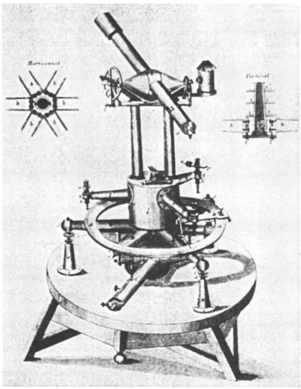
Abb. 3: Hasslers 24-inch Theodolit (60 cm Kreisdurchmesser).
