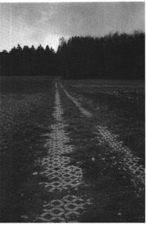
Abb. 1: Zweijährige Versuchsstrecke in Hermrigen (BE). Trotz teilweisen Erdablagerungen sind Rasengittersteine auch im Ackerbaugebiet eine zweckmässige Lösung.
