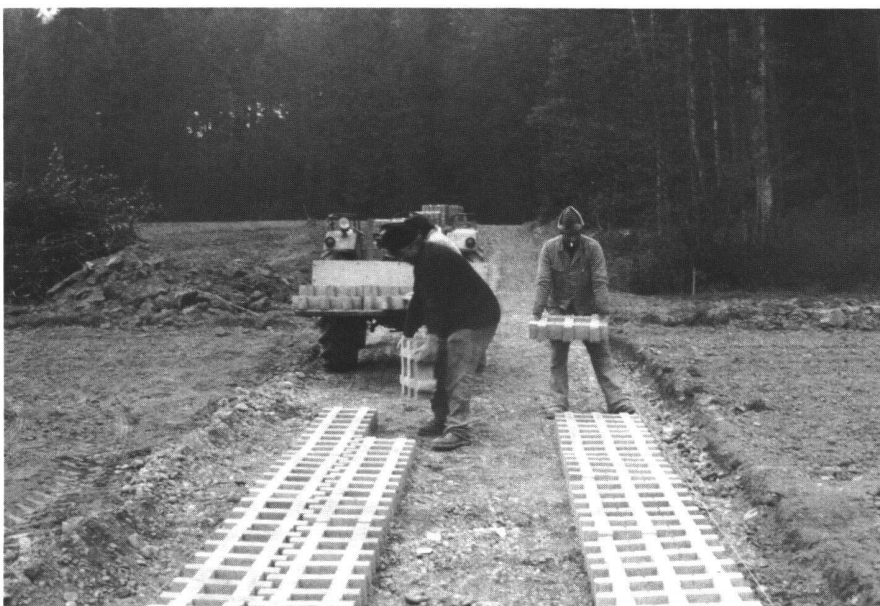
Abb. 8: Das Verlegen der langen schmalen Fahrspuren erfolgt von Hand. Eine schwere Arbeit, die nicht sehr beliebt ist.
