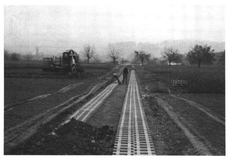
Abb. 3: Als Koffermaterial sowie zum Füllen des Mittelstreifens und der Bankette kann erdig-kiesiges Material aus alten wegfallenden Wegen benützt werden.
