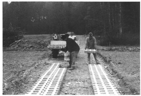
Abb. 8: Das Verlegen der langen schmalen Fahrspuren erfolgt von Hand. Eine schwere Arbeit, die nicht sehr beliebt ist.
