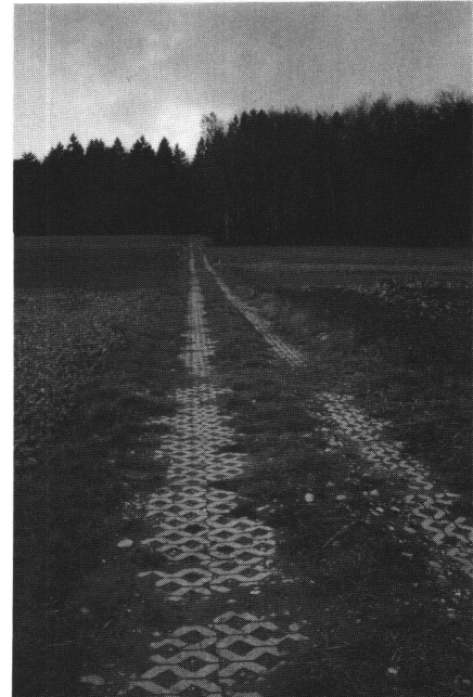
Abb. 1: Zweijährige Versuchsstrecke in Hermrigen (BE). Trotz teilweisen Erdablagerungen sind Rasengittersteine auch im Ackerbaugebiet eine zweckmässige Lösung.
