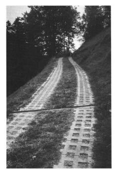
Abb. 6: Zufahrtsweg im Kiental: zwei Jahre nach der Sanierung mit Rasengittersteinen. Max. Steigung 25%. Die einbetonierte Querrinne bewährt sich gut.
