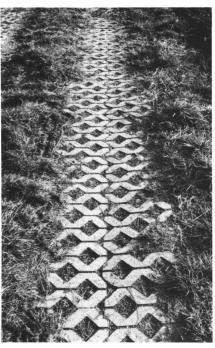
Abb. 9: Häufiges Befahren reinigt die Fahrspur und verhindert das Überwachsen der Steine.
