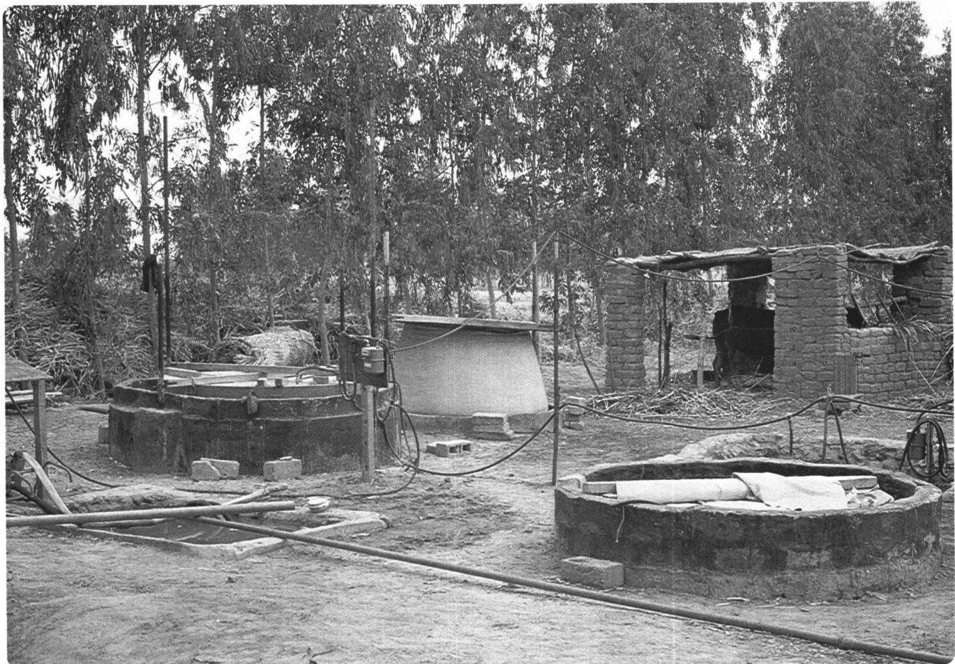
Système de production de biogaz au Niger pour irrigation localisée.
