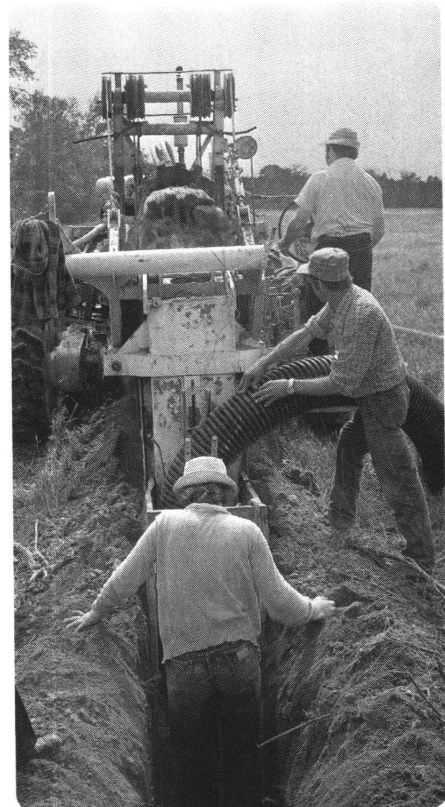
Mise en place d'un collecteur de drainage.
