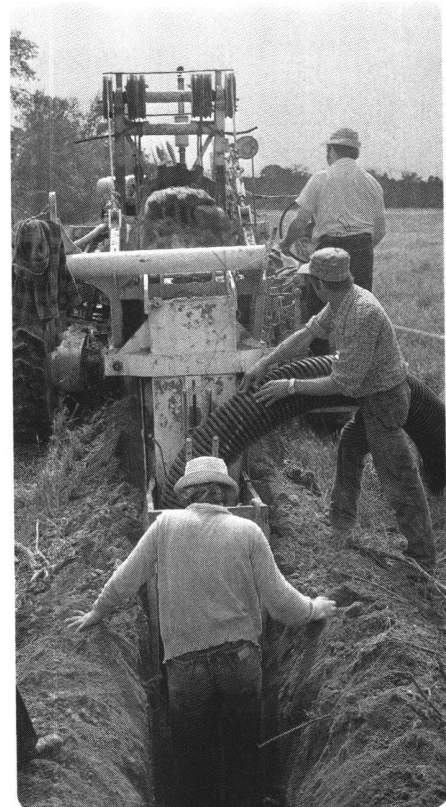
Mise en place d'un collecteur de drainage.
