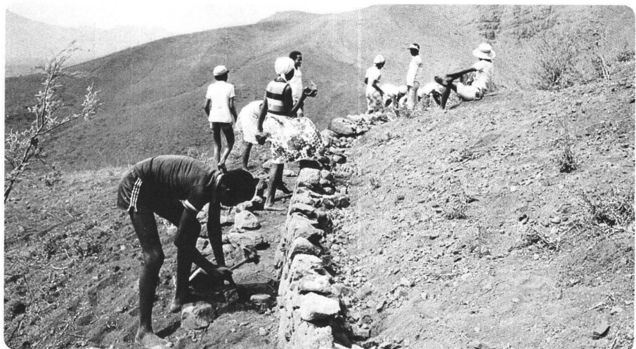
Construction de diguettes anti-érosives au Cap-Vert
