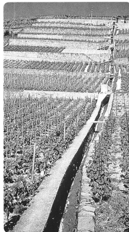
Terrasses anti-érosives et collecteur d'eau de surface à Lavaux.
