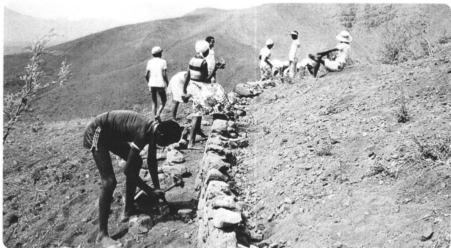
Construction de diguettes anti-érosives au Cap-Vert
