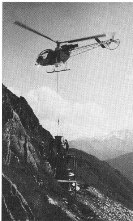
Abb. 14: 400-kV-Mast, Lukmanierleitung, Fundamentbau
