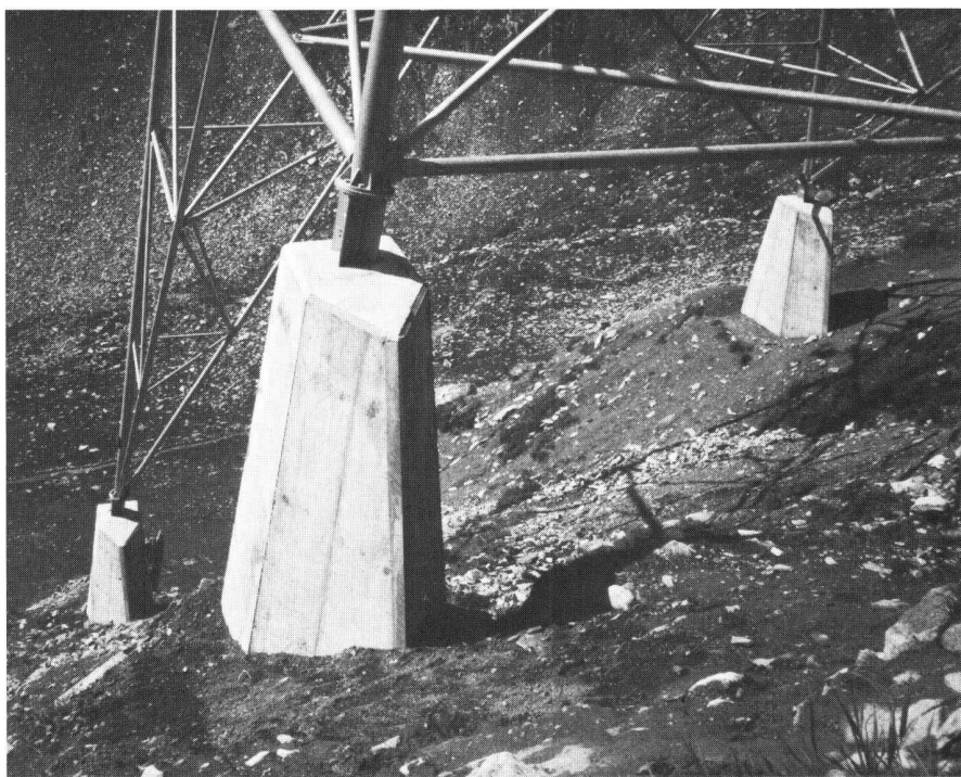
Abb. 15: 400-kV-Mast, Lukmanierleitung, Fundamente mit Lawinenkeil
