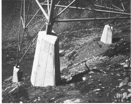
Abb. 15: 400-kV-Mast, Lukmanierleitung, Fundamente mit Lawinenkeil
