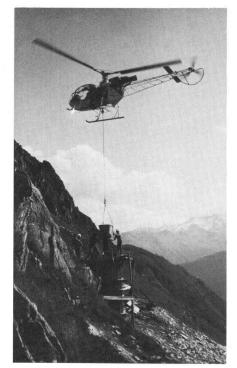
Abb. 14: 400-kV-Mast, Lukmanierleitung, Fundamentbau
