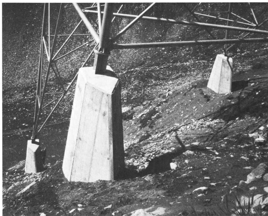
Abb. 15: 400-kV-Mast, Lukmanierleitung, Fundamente mit Lawineneil
