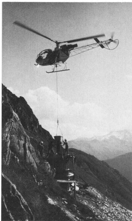
Abb. 14: 400-kV-Mast, Lukmanierleitung, Fundamentbau
