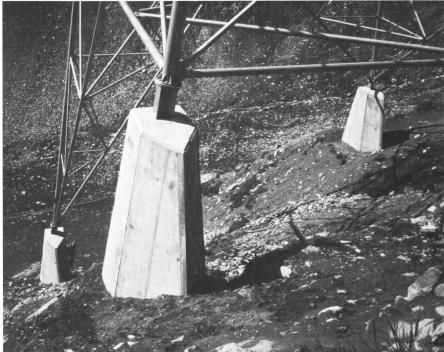
Abb. 15: 400-kV-Mast, Lukmanierleitung, Fundamente mit Lawinenkeil
