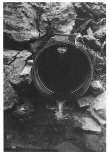
Abb. 2: Auslauf des Strassendurchlass-Rohres (8). Im Rohrinnern ist der Schwenkarm des Mess-Schwimmers (9) zu erkennen.
