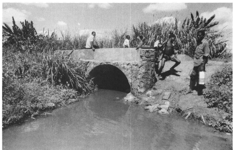
Abb. 1: Strassendurchlässe, Kanalunterführungen übernehmen bei mangelnder sanitärer Versorgung oft die Funktion als Bade- und Waschplätze. Da sie gleichzeitig Brutplätze verschiedener Krankheitsüberträger sind, müssen solche Plätze bei allfälligen Sanierungen besonders ins Auge gefasst werden. (Foto: IfK, Tansania).
