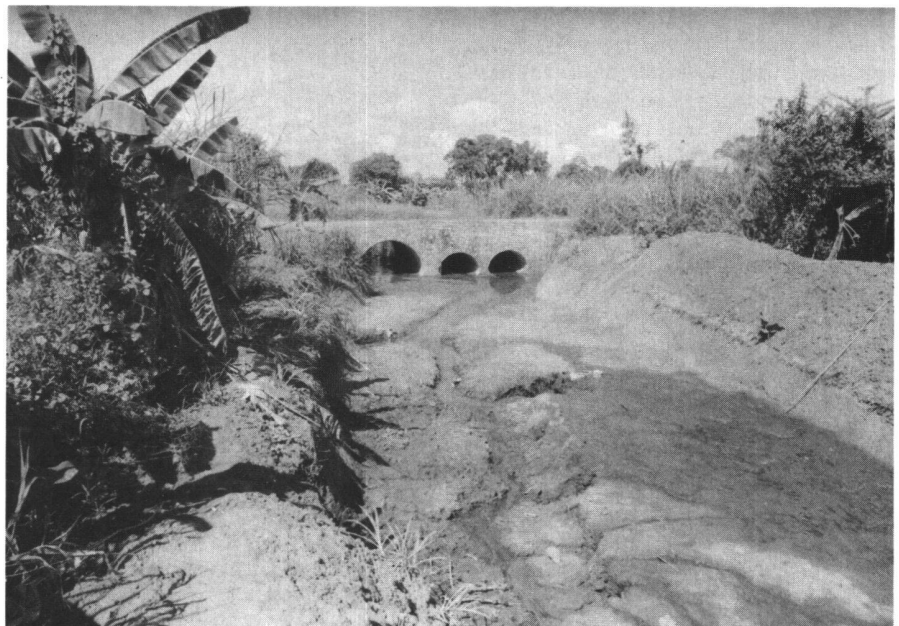
Abb. 3: Möglichkeiten von Environmental Management: Vollständiges Ausräumen und Befreien von Kanälen oder Flussabschnitten von Gras und Wasserpflanzen. Damit werden den Vektoren ihre Lebensgrundlagen zerstört. (Foto: IfK, Kanalunterhalt in Tansania).
