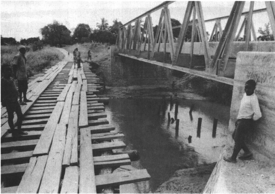
Abb. 2: Überall, wo Verkehrswege Wasserläufe kreuzen, kommt es regelmässig zum Kontakt «Mensch-Wasser» und damit zu einer möglichen Krankheitsübertragung. (Foto: IfK, Brückensanierungen in Tansania).
