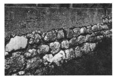
Abb. 4: Ein pikantes Detail am Pilgerweg ist diese alte Bruchsteinmauer mit aufgesetzter Betonkrone.
