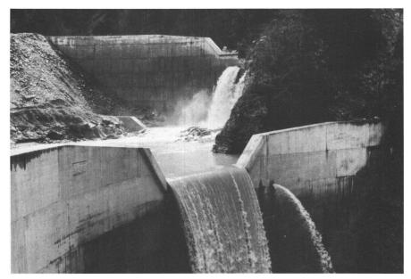
Abb. 1: Wildbachsperren am Schraubach (GR), mit Absturzhöhen von ca. 12m. Die VAW untersuchte den Kolkvorgang und die Kolksicherung.
