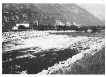
Abb. 3: Blockschwelle im Tessin bei Lodrino, mit einer Absturzhöhe von ca. 5 m. Die Anordnung der Schwelle ergab sich aus dem hydraulischen Modellversuch. Insbesondere wurde eine rauhe Oberfläche empfohlen, was die Kolkbildung vermindert und den Aufstieg von Fischen und Kleintieren ermöglicht.
