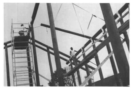
Abb. 2: Rundholzbauweise – Ein eigenleistungsfreundliches Bausystem (Foto: Bieri, Überstorf).
