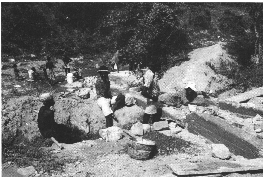
Abb. 2: Bau einer Wasserrfassung bei Jean Rabel, Haiti.
