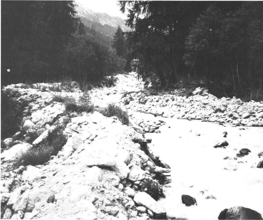
Abb. 6: Flussabschnitt des Rom bei Valchava. Links und rechts im Bild sind provisorische Korrekturarbeiten durch einen Bagger sichtbar.
