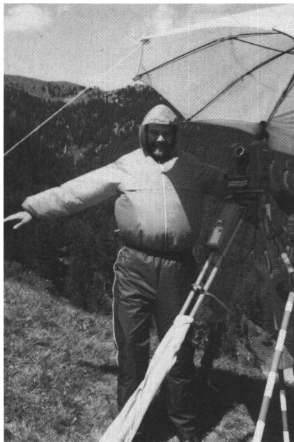
Abb. 2: Diplomvermessungskurs Valle Blenio 1985: Die Studenten triangulieren im Netz 4. Ordnung.
