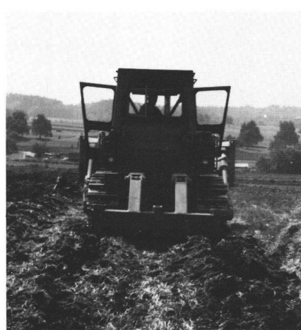
Abb.9 Cat D7G mit zwei Aufreissern im ersten Durchgang.
