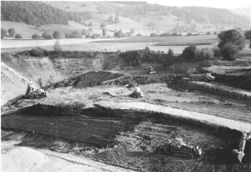
Abb. 7 Rekultivierungsarbeiten Degerfeld der Firma S. Amsler in Schinznach-Dorf. Praktisch gleichzeitig wurden Teile der Rohdeponie (hinten) und des Unterbodens (Mitte) geschüttet, während das Tieflockerungsgerät (vorne rechts) im Betrieb war und bereits der Humus aufgetragen wurde (vorne links).
