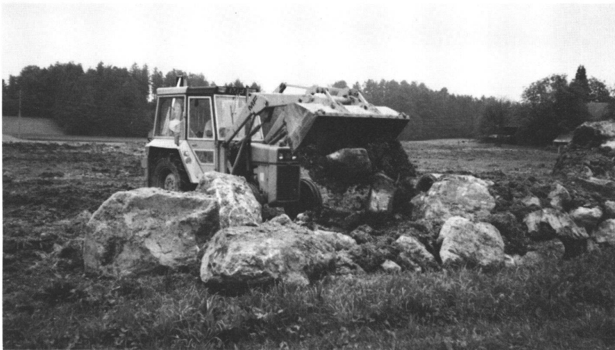
Abb. 7 Sanierung einer alten, nicht gelungenen Rekultivierung in Horgen. Die Steine wurden dem Unterboden entnommen und zeigen einen offensichtlichen Grund des Misserfolges der Rekultivierung.
