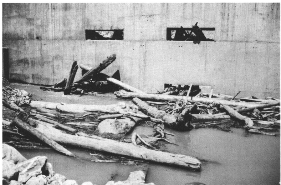
Abb.4 Das Treibholz verstopft die Sperrenöffnungen und führt zu unerwünschtem und nicht vorhersehbarem Rückstau.
