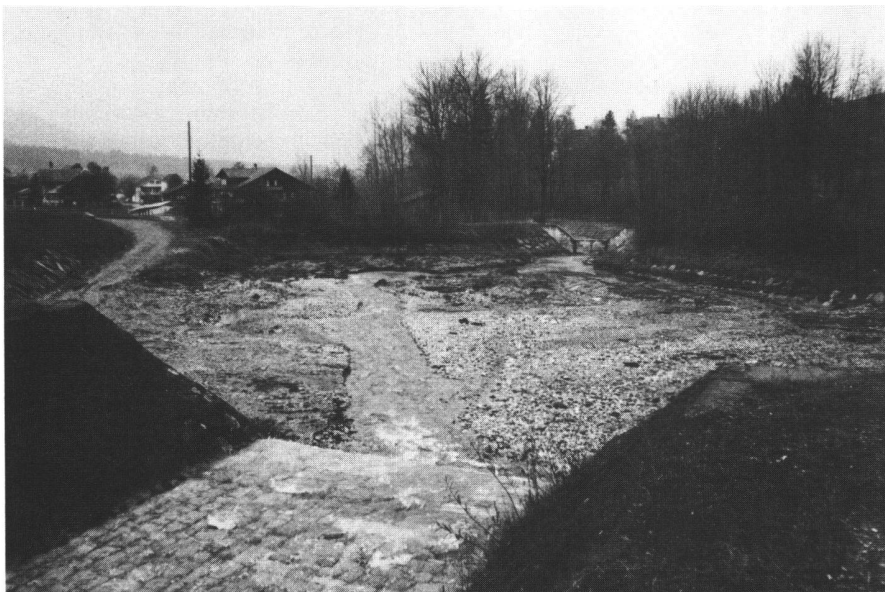
Abb. 10 Ablagerungsplatz des Fallbaches bei Blumenstein/BE. Im Vordergrund der Einlauf, in der rechten hinteren Bildmitte die Rückhaltesperre.
