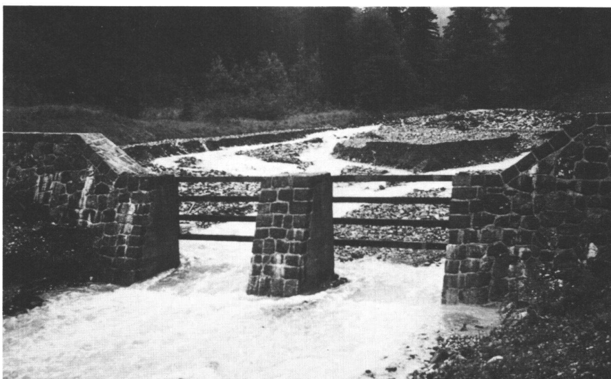
Abb. 7 Geschiebeablageungsplatz Spielbergbach (Fieberbrunn, Kitzbühel, Österreich). Im obersten Bild sieht man das Becken nach seiner Fertigstellung 1972 (Sperrenhöhe 3,2 m), im mittleren Bild den mit 20 000 m 3 gefüllten Ablagerungsplatz im Juni 1975 (Einzugsgebiet 6,9 km 2 , ca. 20- bis 30jähriges Ereignis), und im untersten Bild das Becken nach seiner selbsttätigen Entleerung von ca. 13 000 m 3 innerhalb von vier Wochen nach Beseitigung der Verklausungen an der Rückhaltesperre. (Fotos E. Hanausek, Innsbruck.)
