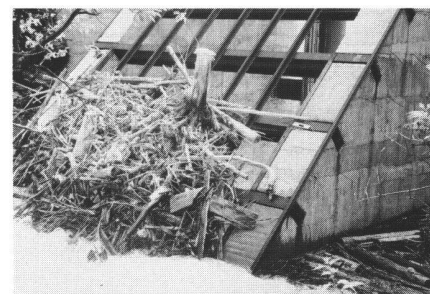
Abb.9 Rückhaltebauwerk mit Schrägrechen in der Köttschache (Badgastein, Österreich). Das Treibholz hängt im Rechen, während das Wasser und Geschiebe noch unten durch fliessen kann. (Foto W.Kettl, Salzburg.)
