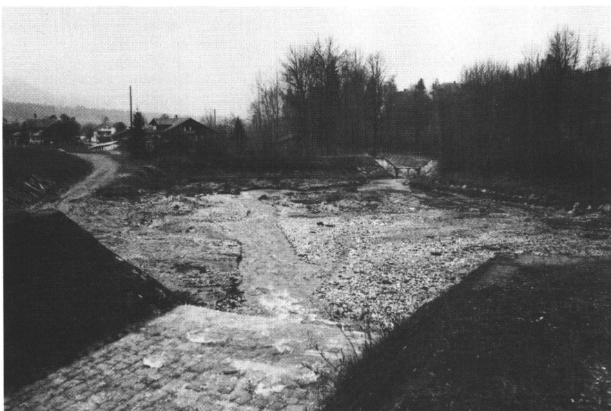
Abb. 10 Ablagerungsplatz des Fallbaches bei Blumenstein/BE. Im Vordergrund der Einlauf, in der rechten hinteren Bildmitte die Rückhaltesperre.
