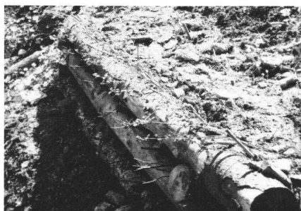
Abb. 10 Durch die Pflanzen der Heckenlagen im Holzkasten wird die Konstruktion beschattet und der Feuchtigkeitsgehalt stabilisiert. Dadurch wird die Funktionsdauer der Hölzer verlängert.
