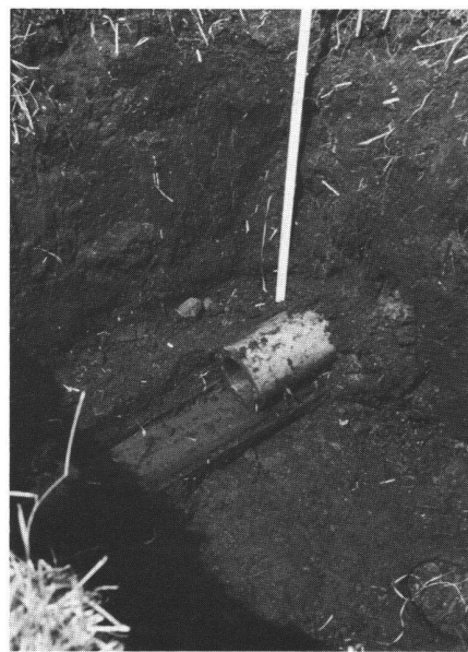
Abb. 4 Altes Tonrohr im Lüscherzmoos. Das Füllmaterial des Draingrabens kann vom ungestörten Torf nicht unterschieden werden.
