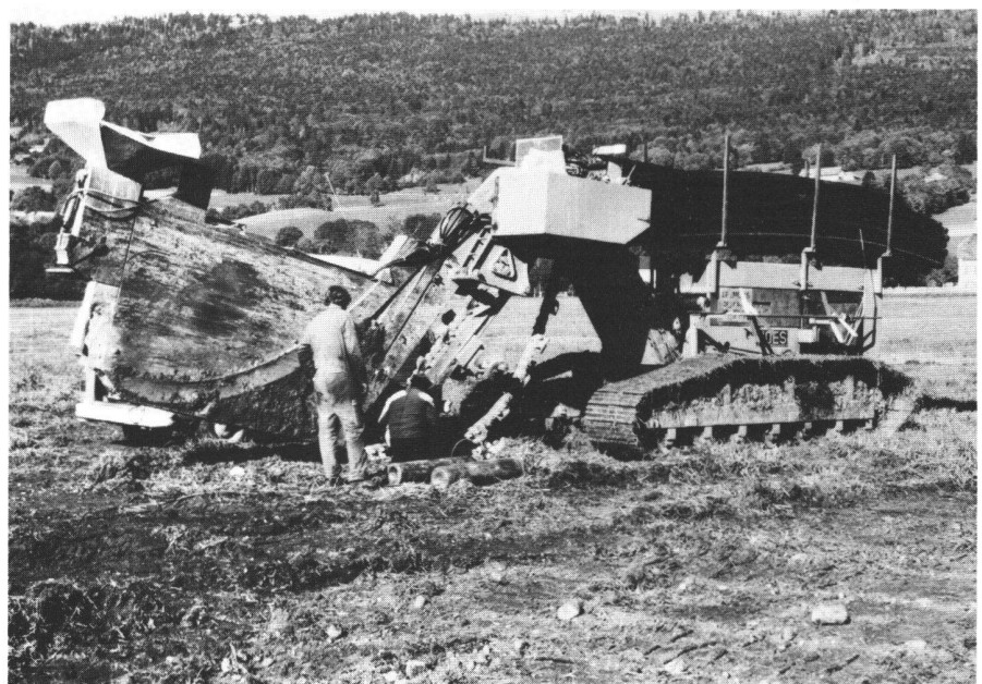
Fig. 7 Drainage 1983, draineuse, réparation de la chaîne
