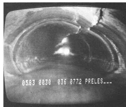
Fig. 5 Contrôle par TV, tuyau ovalisé (photo Krähenmann) (mai 1983, Ø 30, photo 36, à 77,2 m de la chambre)
