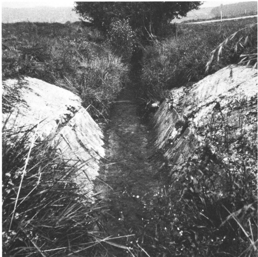
Fig. 6 «La Douanne», état des caniveaux et dalles, 1980
