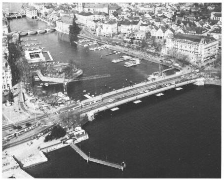
Abb. 1 Die neue Brücke wird limmatseitig auf Pfählen erstellt
