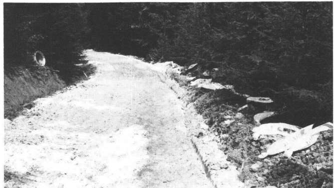
Abb. 2 Bei neuen Wegen im weichen Waldboden ist oft eine Stabilisierung mit Kalk oder Zement von Vorteil. Eingesandte Bodenproben werden vom Labor der Betonstrassen AG in Wildeggen untersucht. Die notwendige Bindemittelmenge pro Quadratmeter wird dort festgestellt. Auf der Baustelle wird das Bindemittel, in Chabrey Kalk (siehe leere Säcke am rechten Bildrand) von Hand ausgestreut und mit Scheibeneggen in den Beton eingearbeitet. Anschliessend wird maschinell planiert und mit Walzen verdichtet. Das dem Gelände angepasste Planum ist gleichzeitig Transportpiste.
