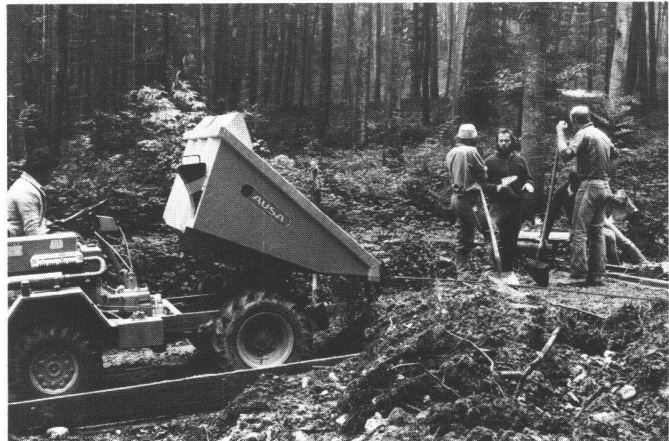
Abb. 4 Der Dumper kippt den Frischbeton vor Kopf, worauf er von Hand mit Schaufeln auf die notwendige Breite verteilt wird.
