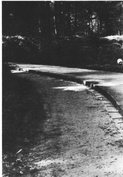
Abb.8 Von der Försterschule Lyss mit einem Fertiger auf einem alten wassergebundenen Schotterweg erstellter Betonweg (Maschineneinbau).
