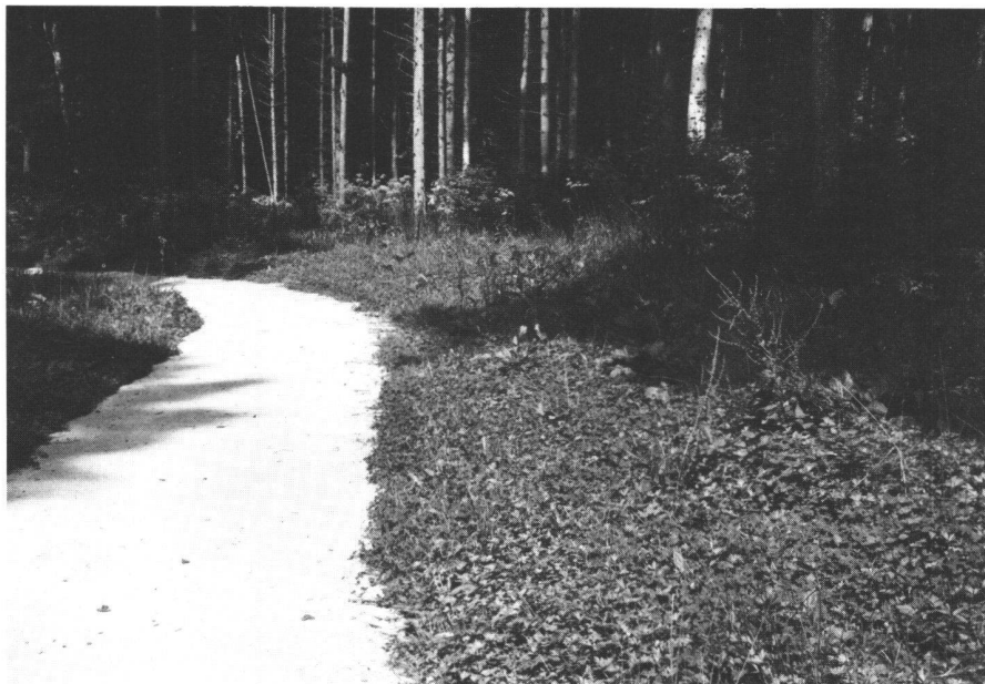
Abb.9 Älterer Forstweg mit Betonbelag in der Nähe von Chabrey. Von beiden Seiten wachsen die Waldpflanzen auf den Weg hinein. Der Betonbelag ist ein Wegbelag, der durch diesen Bewuchs keinen Schaden erleidet, ein besonders hinsichtlich Unterhaltsfreiheit nicht zu unterschätzender Vorteil dieser Belagsart. (Fotos: Betonstrassen AG, 5103 Wildegg)
