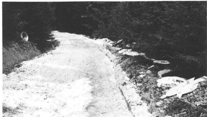
Abb. 2 Bei neuen Wegen im weichen Waldboden ist oft eine Stabilisierung mit Kalk oder Zement von Vorteil. Eingesandte Bodenproben werden vom Labor der Betonstrassen AG in Wildeggen untersucht. Die notwendige Bindemittelmenge pro Quadratmeter wird dort festgestellt. Auf der Baustelle wird das Bindemittel, in Chabrey Kalk (siehe leere Säcke am rechten Bildrand) von Hand ausgestreut und mit Scheibengegen in den Beton eingearbeitet. Anschliessend wird maschinell planiert und mit Walzen verdichtet. Das dem Gelände angepasste Planum ist gleichzeitig Transportpiste.
