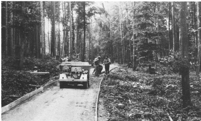
Abb. 3 Antransport des Frischbetons auf einem alten Forstweg mit einem Dumper beim Handeinbau. Die seitlichen Schalungen bestehen aus senkrecht gestellten Brettern, deren Breite = Betonstärke minus 1 Zentimeter ist. Auf ihnen gleitet die Doppelrüttelbohle.
